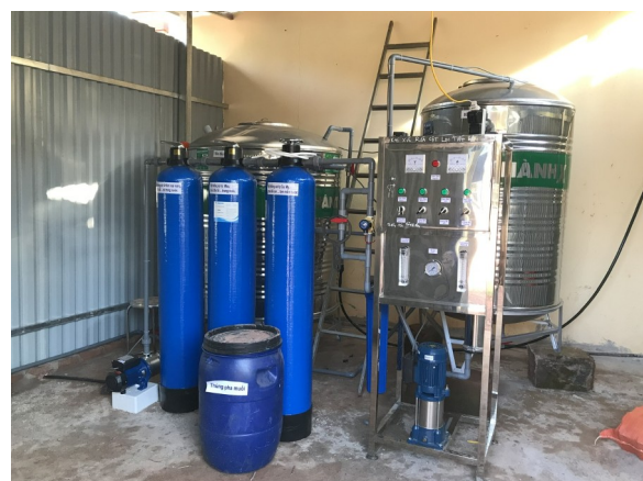
Waterfiltratie installatie Na Co Sa.
