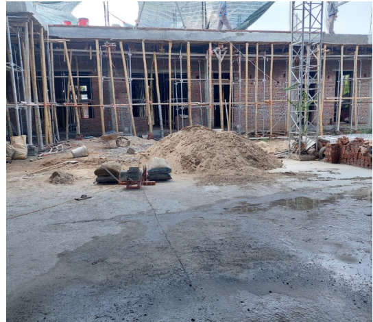
Bouw van de trainingsruimte in Trung An.
