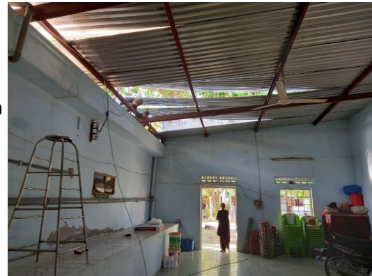
Situatie voor de renovatie
