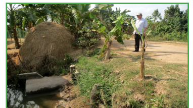
Om de weg veiliger te maken is een doorlaat voor het water gemaakt
