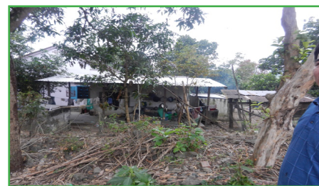
Regenwater wordt opgevangen in plastic tonnen, maar dat is niet genoeg voor het hele jaar.
